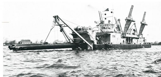
Diepzuiger "Beverwijk 39" van N.V. van Hattum en Blankevoort te Beverwijk, gebouwd door N.V. Scheepswerf Stapel te Spaarndam en voorzien van 1000 + 600 pk Lister Blackstone motoren voor aandrijving van één zandpompgenerator, 495 pk Lister Blackstone motor voor aandrijving van de waterpomp en 337 pk Lister Blackstone motor voor aandrijving van D.C. generator.
